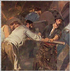
Les ouvriers manœuvrent un marteau-pilon : inventée vers 1840, cette machine fonctionne à la vapeur.
